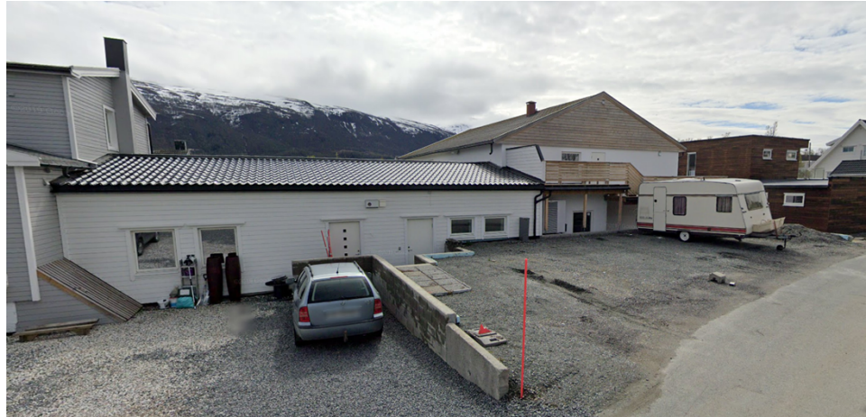
Eksisterende bygning sett fra Lanesvegen. Google Street View mai 2019
