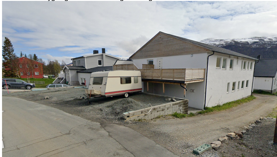
Eksisterende bygning sett fra Lanesvegen. Google Street View mai 2019
