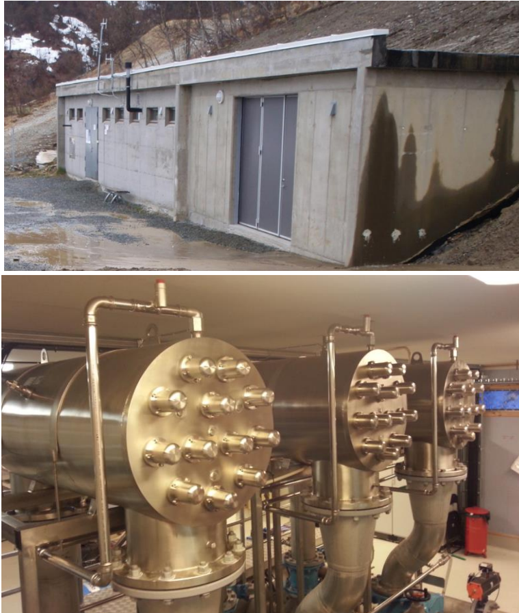
Figur 11: Kvaløya Vannbehandlingsbygg (øverst) med eksisterende UV-aggregat (nederst).
