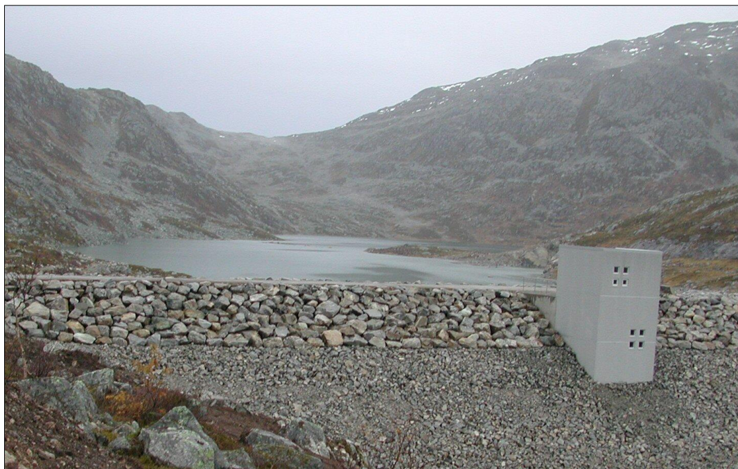
Figur 10: Damanlegget ved Øvre Langvatn.
