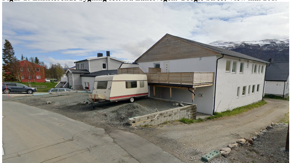
Figur 3: Eksisterende bygning sett fra Lanesvegen. Google Street View mai 2019
