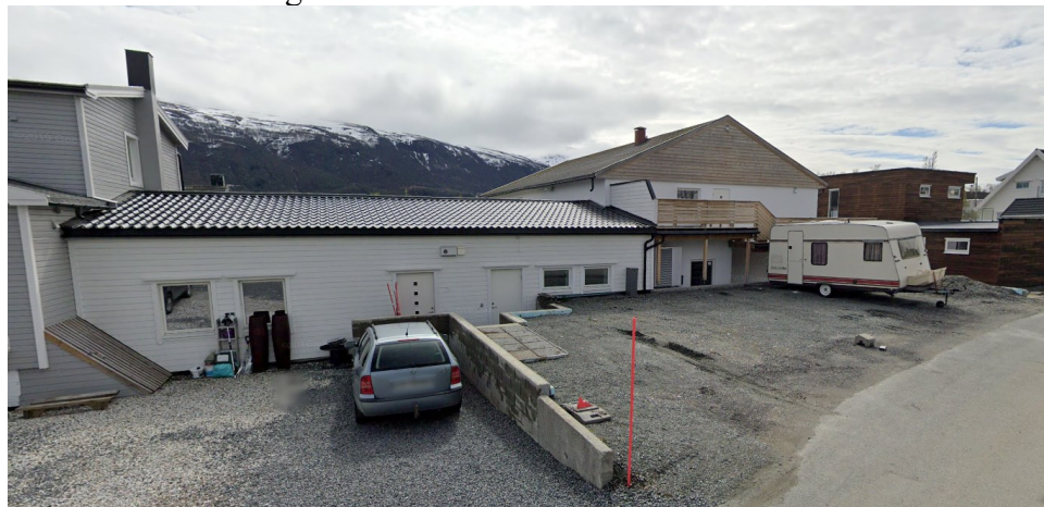
Figur 2: Eksisterende bygning sett fra Lanesvegen. Google Street View mai 2019
