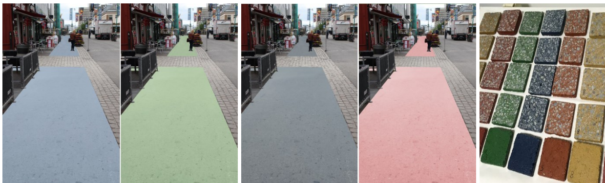
Figur 1: Eksempler på farget asfalt som kan legges i gangsoner (skiferdekket) i påvente av en full oppgradering av Storgata nord.
