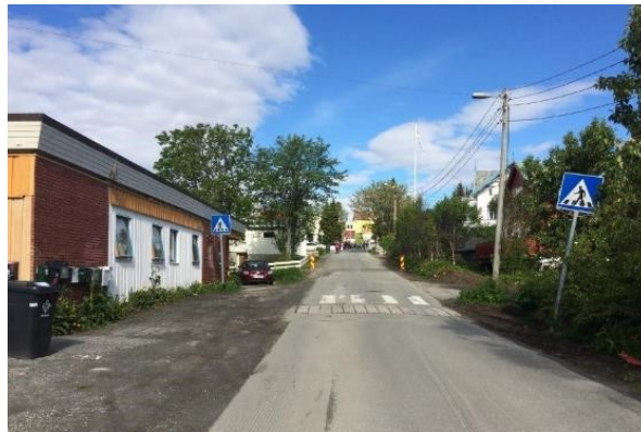
Eksisterende situasjon Bjerkakervegen ved nr.14
